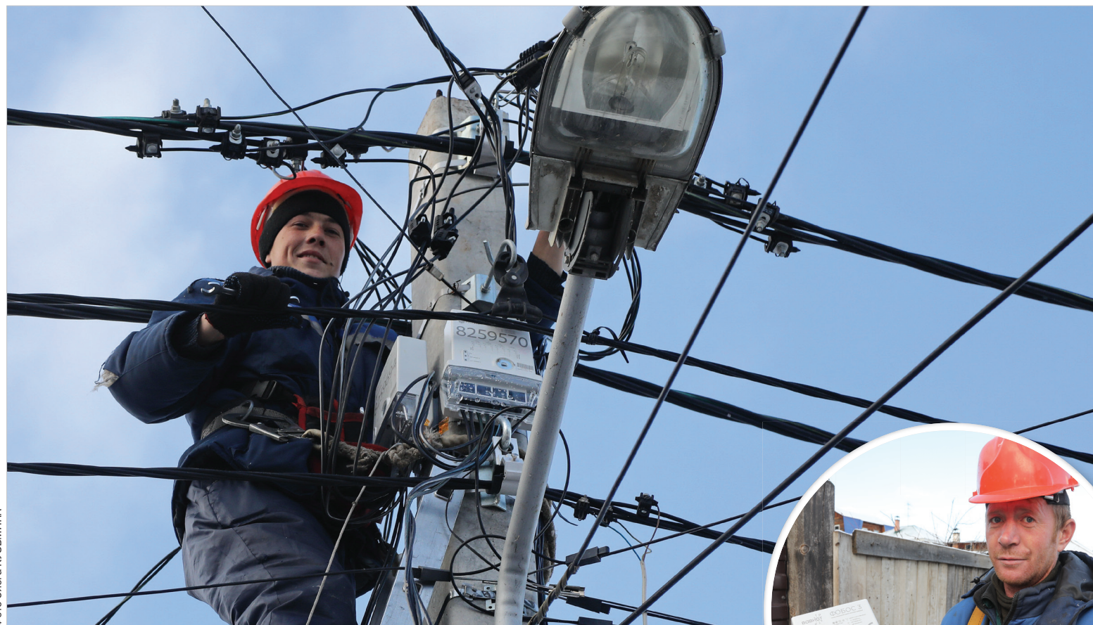
Счетчики крепятся непосредственно на воздушных линиях электропередачи в точках присоединения проводов частных домов к уличным сетям. Они фиксируют реальную мощность, которую потребляют абоненты
